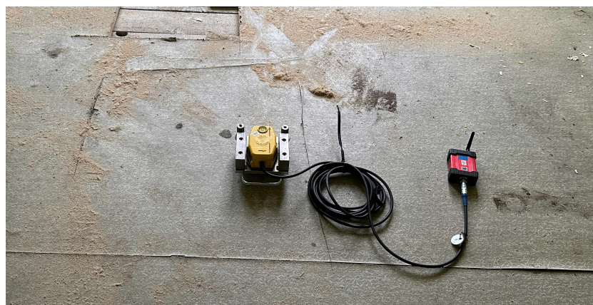
Abb. A5: MP 4 im 2.OG des Gebäudes Bahnhofplatz 4
