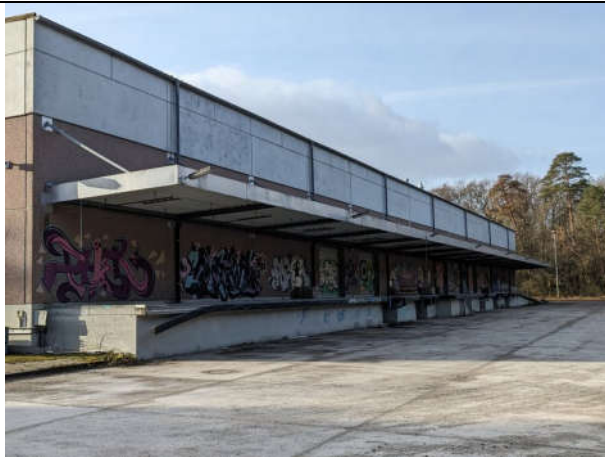
Foto Nr. 3: Nordseite des Ware House (Gebäude 3) mit Laderampe und Vordach. Sehr ähnlich sieht die Südseite aus.
