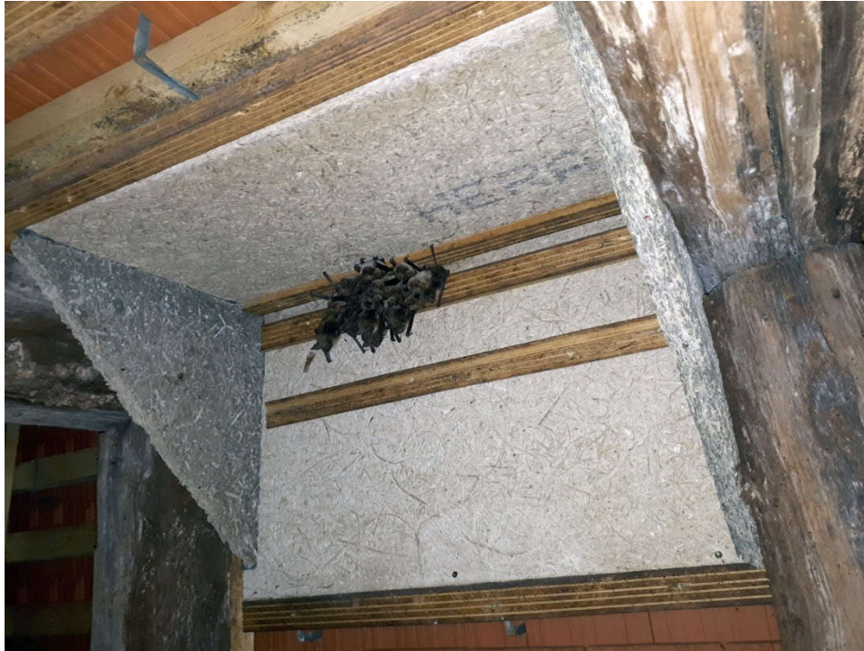
Abbildung 4: Beispiel für eine Wärmeglocke aus Heraklitplatten für Große Mausohren an einer geraden Decke in Happurg. Foto: R. Leittl, 24.03.2022, zur Verfügung gestellt von M. Hammer, Koordinationsstelle für Fledermausschutz Nordbayern.
