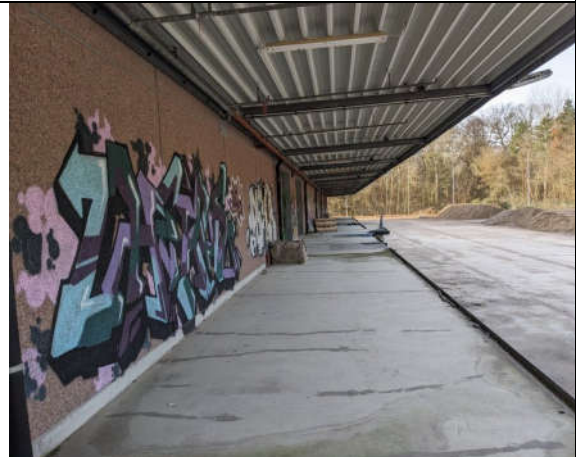
Foto Nr. 4: Blick über die vom Vordach beschatteten und gegen Regengeschützte Laderampe.
