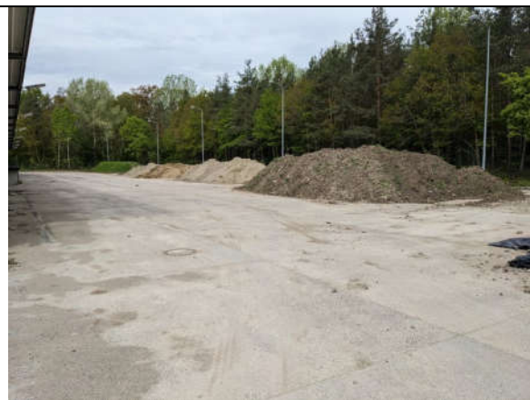
Foto Nr. 7: Erdmieten auf der Nordseite der Hoffläche – hier sollen zukünftig die Materialboxen für Erdblagerungen und andere Materialien stehen.
