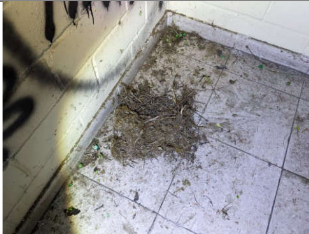
Foto Nr. 12: Heruntergerissenes Hausrotschwanznest im Treppenhaus im Ware House (Gebäude 3).
