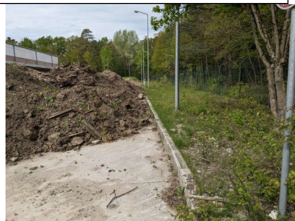
Foto Nr. 8: Erdschüttung bis an die Grenze zum Eidechsenhabitat – die Erdhaufen werden bei geeigneter Konsistenz von den Eidechsen besiedelt und zu Eiablage genutzt werden.
